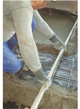
Proteger con polietileno de 100 micrones solapado. Por encima, el contrapiso armado.
