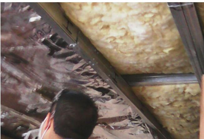
Por debajo se instala Rolac Plata ancho 0,40 m con el foil de aluminio hacia abajo.
