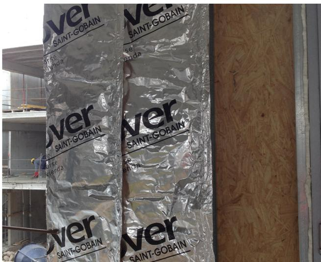
1. Rolac Plata Muro - ancho 0,40 m - se coloca entre montantes.
