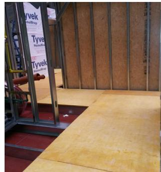
Los paneles PF100 e=20 mm se colocan a tope sobre la placa de OSB o fenólico.
