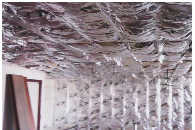
La solapa longitudinal pasa por delante de los perfiles. Los paños se unen con cinta de aluminio autoadhesiva.
