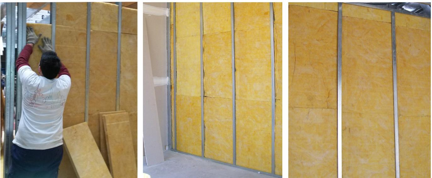
Los paneles Acustiver P se cortan a pie de obra y se instalan entre los montantes a tope cubriendo toda la superficie.
