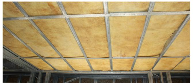
Acustiver R se presenta precortado en 0,40, 0,48 y 0,60 m y se instala perfectamente entre los perfiles estructurales.
